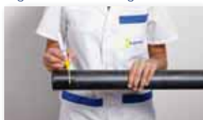
Marcare la profondità d'inserimento.
