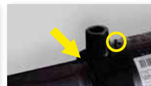
Leer el código de barras e iniciar la soldadura. Realizar los controles necesarios (alineación, profundidad de inserción e indicadores de fusión).
