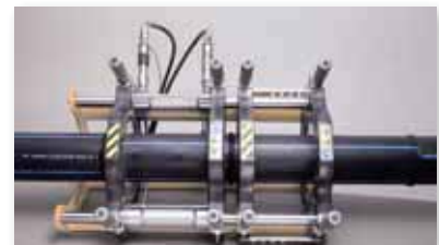
Fase 5 saldatura con gli elementi in pressione
