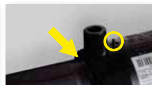
Lisez le code à barres et commencer la soudure. Effectuer les contrôles nécessaires (alignement, profondeur d'insertion et indicateurs de fusion).
