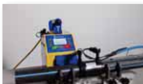
Leggere il codice a barre ed avviare la saldatura. Effettuare i controlli previsti (allineamento, profondità d'inserimento e indicatori di fusione).
