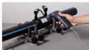
Leggere il codice a barre ed avviare la saldatura. Effettuare i controlli previsti (allineamento, profondità d'inserimento e indicatori di fusione).
