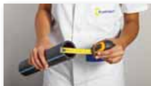
Controllare le dimensioni degli elementi da saldare.
