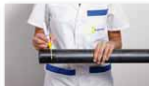
Et utiliser les gratteurs spéciaux. Nettoyez les surfaces avec un détergent approprié. Marquer la profondeur d'insertion.
