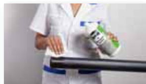
Et utiliser les gratteurs spéciaux. Nettoyez les surfaces avec un détergent approprié. Marquer la profondeur d'insertion.
